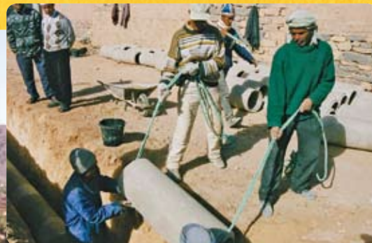
Réalisation du réseau d'assainissement (Oasis de Figuig, Maroc - Conseil Général Seine Saint Denis)
