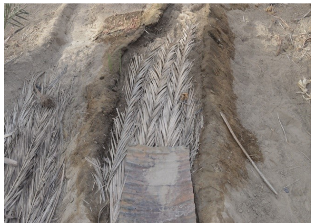
Photo 6 : Des feuilles de dattiers revêtant les canaux d'irrigation
