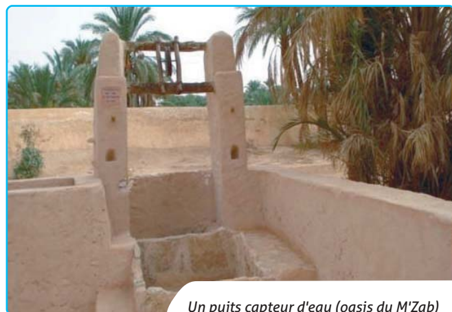
Un puits capteur d'eau (oasis du M'Zab)
