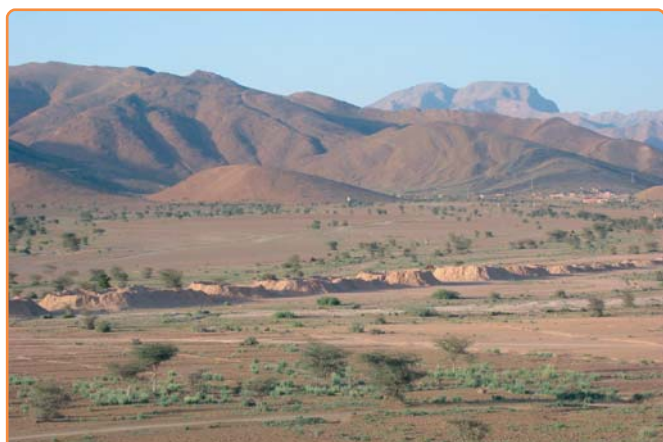
Enfilade des puits de déblaiement d'une khettara (Maroc)
