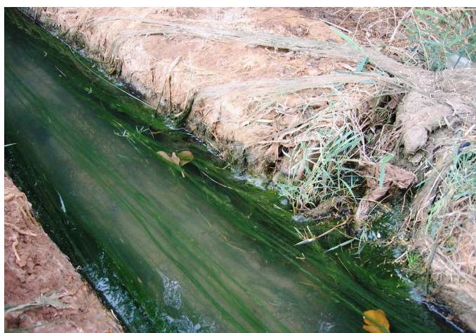
Figure 42 : algues envahissant le canal d'une khattara (photographie le 20-09-07 sur la Souihla O. Gh)
