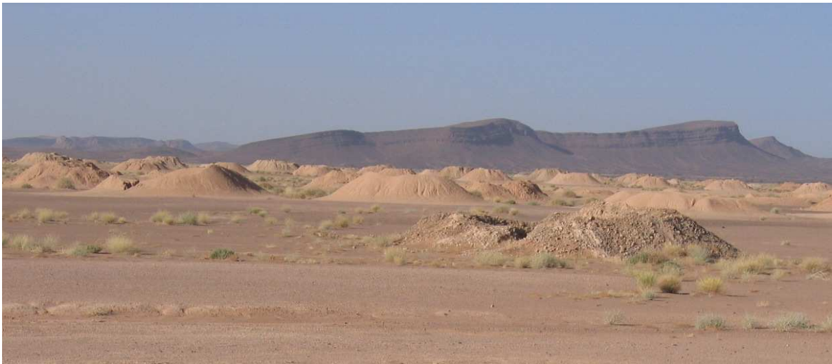
Figure 37 : alignement de puits au dessus des galeries des khattaras. Amont de Jorf, 18-06-07.
