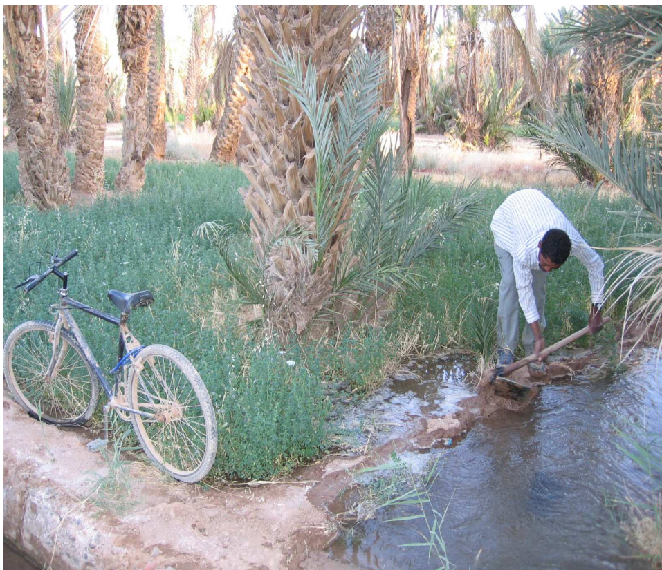
Figure 24 : ouverture d'une prise d'eau sur le canal en terre pour irriguer une parcelle de luzerne (photographie prise à Ouled Ghanem le 13-06-07)
