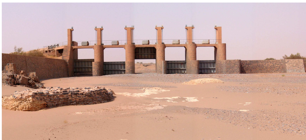
Figure 4 : barrage de dérivation des crues de Kfifet, Fezna. Source : personnelle.
