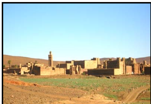
Vue générale du douar Elfalggara
