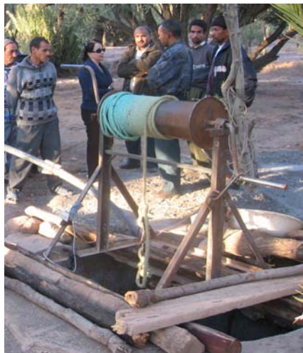
Puits en construction
